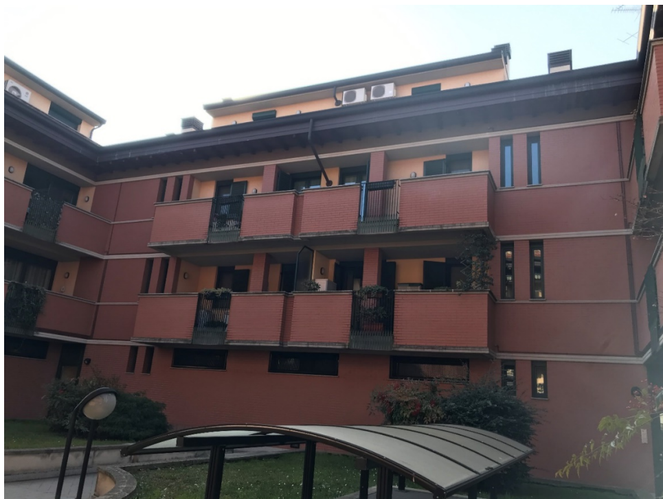
Foto n. 2: Prospetto su cortile interno.
