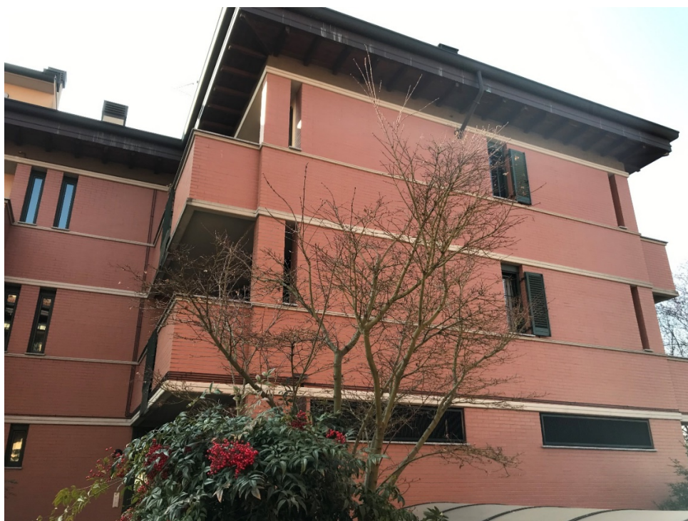
Foto n. 3: Particolare del prospetto interno.
